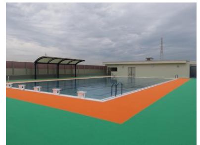
= 屋上のプール =
