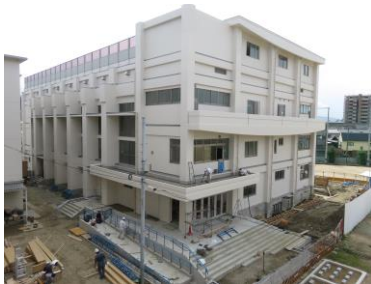
= 体育館正面玄関付近 =
